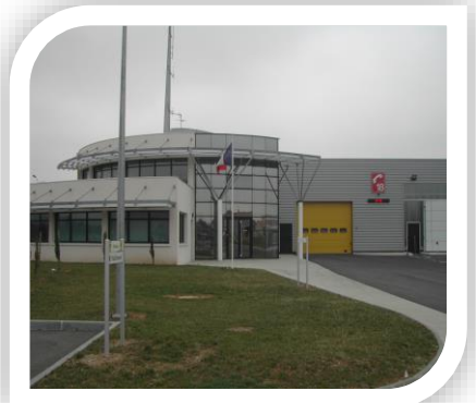
Caserne des sapeurs-pompiers de Romans
